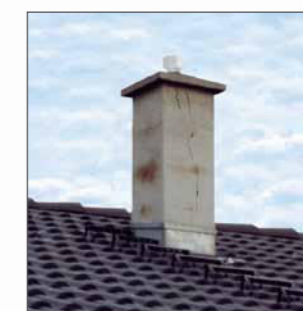
Bis außen durchgehende Risse im Schornstein.
